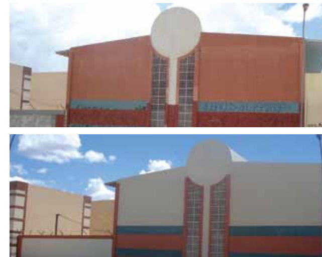
Fachada da escola antes da reforma (em cima) e o Centro Educacional após a revitalização (embaixo)
